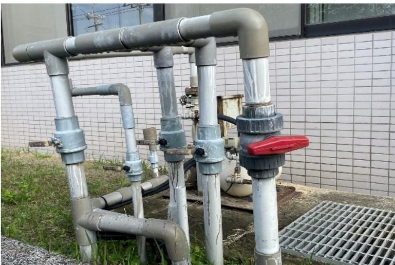
公司設有雨水貯集回收利用裝置，雨水經過簡單的過濾系統過濾雜質靜置後，所收集的雨水可作為沖廁澆灌用水，以及園藝澆花之用，減少自來水的使用，增進水資源再利用。
